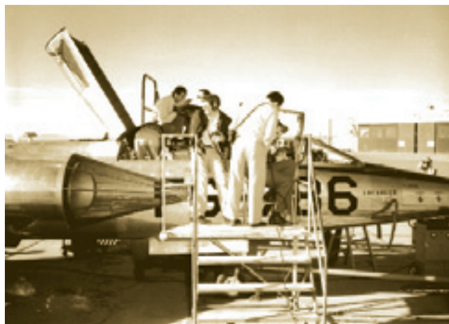
Проверка аппаратуры РЭО на XF-104 (53-7786). Авиабазы Эдвардс. Обращает внимание не типичное открытие люка отсека РЭО. На серийных самолетах люк открывался в левую по полету сторону. Апрель 1954 год
